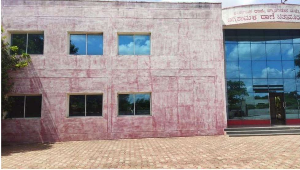
ಚಿತ್ರ 90: ಚಿತ್ತಾಪುರ ಅಗ್ನಿಶಾಮಕ ತಾಣೆಯಲ್ಲಿ ಬಾಹ್ಯ ಬಣ್ಣಕ್ಕೆ ಕಳಪೆ ಗುಣಮಟ್ಟದ ಬಣ್ಣ ಬಳಸಲಾಗಿದೆ
