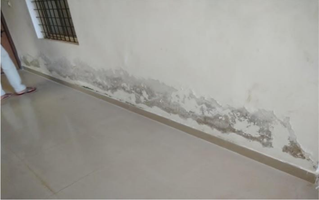
ಚಿತ್ರ 89: ಚಿಕ್ಕಬಳ್ಳಾಪುರ ಅಗ್ನಿಶಾಮಕ ತಾಣೆಯಲ್ಲಿ ಸಾಮಾನ್ಯ ಪ್ರದೇಶಗಳಲ್ಲಿ ನೀರಿನ ಸೋರಿಕೆಗೆ ಕಾರಣವಾಗುವ ಕಳಪೆ ಗುಣಮಟ್ಟದ ನಿರ್ಮಾಣ
