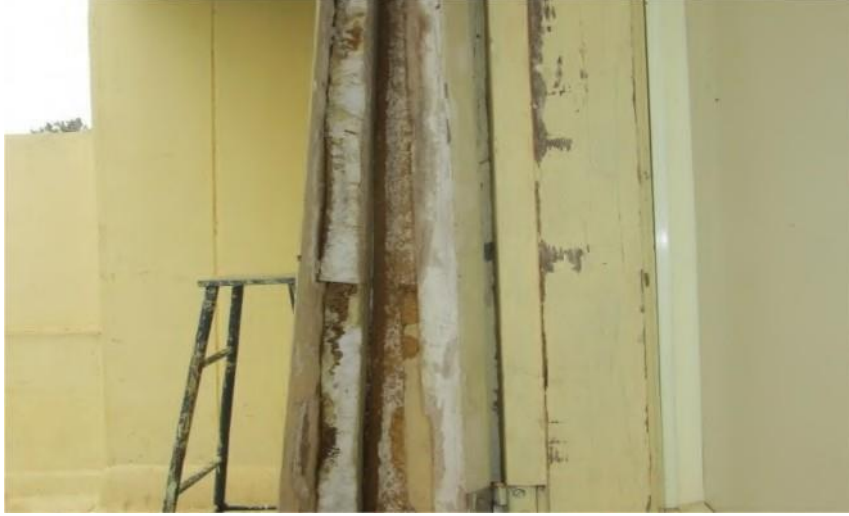
ಚಿತ್ರ 96: ಯಲಹಂಕದ PDMS ತರಬೇತಿ ಮತ್ತು ಹಾಸ್ಟೆಲ್ ಗಳಲ್ಲಿ ಕಳಪೆ ಗುಣಮಟ್ಟದ ಬಾಗಿಲುಗಳು
